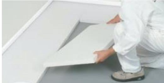
Trittschalldämmplatte aus expandiertem Polystyrolhartschaumstoff für Gesamtbelastungen bis 650kg/m<sup>2</sup>
